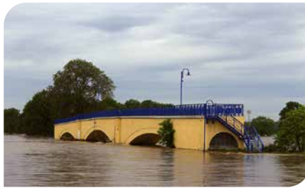
Das Aquädukt am 3. Juni 2013 bei Hochwasser der Mulde – wie viele Freiwillige stopfte auch der Autor den gebrochenen Damm, Tonnen von Sand wurden täglich mit Händen bewegt.
